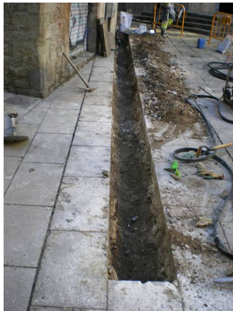
4. Vista general de la rasa.
