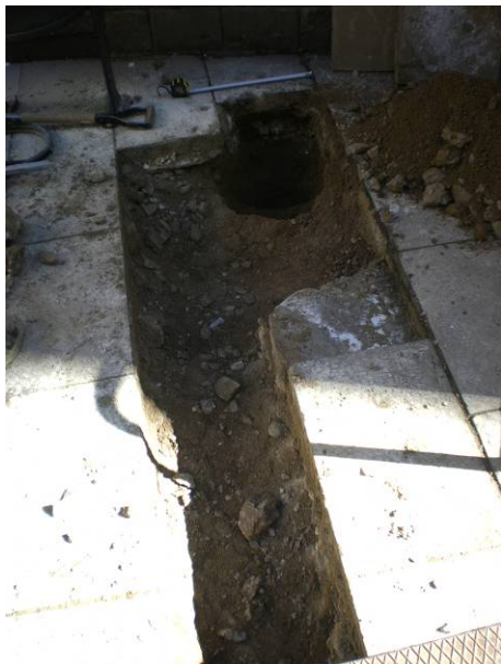
5. Vista general de la rasa un cop acabada
