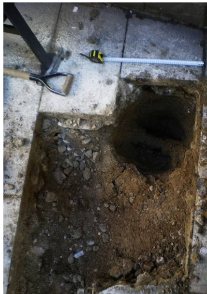
6. Detall de la rasa un cop acabada.
